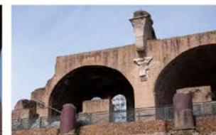
izquierda: Restos en parte del entablamiento de mármol de la basílica aún hoy incrustado en la estructura de ladrillo. Servía, en gran medida, como mera decoración, pues la estructura se sustentaba sobre los arcos torales de ladrillo que se colocan sobre ellos. Derecha: Todavía se conservan algunos fragmentos de las columnas de pórfido que decoraban la fachada y que le daban el imponente aspecto que hemos recreado.
